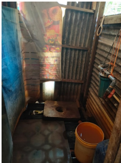
Gambar 6 Kondisi Jamban Eksisting
