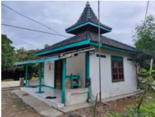
Gambar 4. Foto Tampak Samping Kanan Mushola
