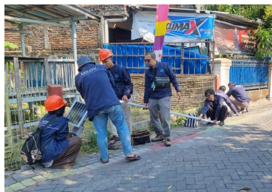
Gambar 4. Pemasangan PJU panel surya
