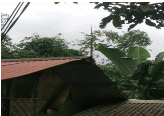
Gambar 4. Pemasangan penangkal petir.
