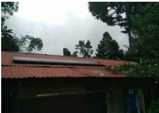
Gambar 3. Pemasangan panel surya di atap.
