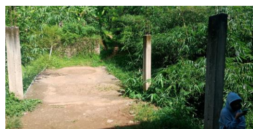
Gambar 8. Sebelum pemasangan di tiang
