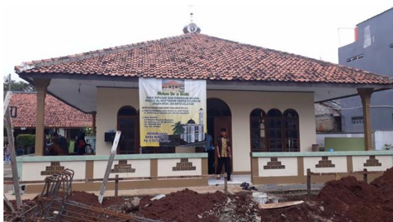
Gambar 1. Kondisi eksisting Masjid Al Muttaqin sebelum direnovasi masih berupa musholla dan masih satu lantai, rencana pengembangan adalah memperluas bangunan ke samping dan ke atas
