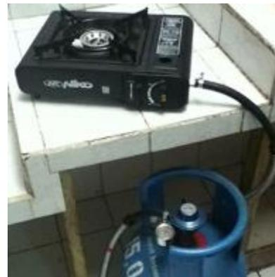
**Gambar 12.** Peletakan kompor dan tabung gas dalam jarak yang aman
