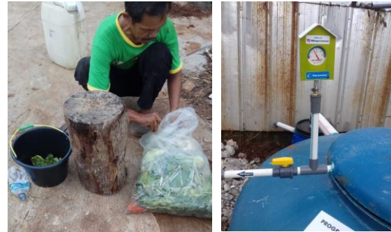
Gambar 5. Persiapan sampah organik untuk dimasukkan ke dalam biodigester dan tekanan yang ditunjukkan di dalam biodigester.
