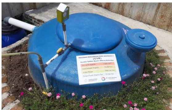
Gambar 4. Biodigester yang sudah terpasang
