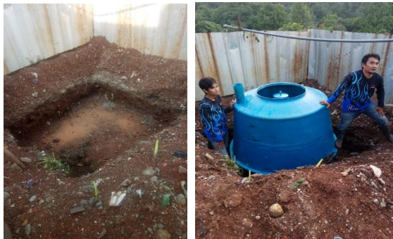
Gambar 3. Proses pemasangan / instalasi biodigester di lokasi
