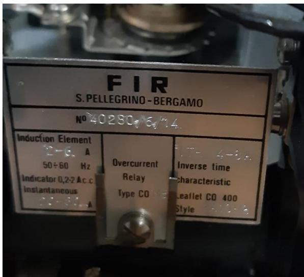
**Gambar 7.** Spesifikasi Overcurrent Relay pada motor FDFan
