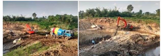
Gambar 13. Penuangan beton menggunakan excavator
