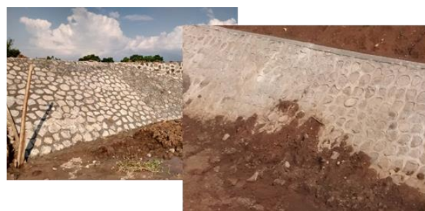
Gambar 15. Variasi bentuk siaran dalam pemasangan batu
