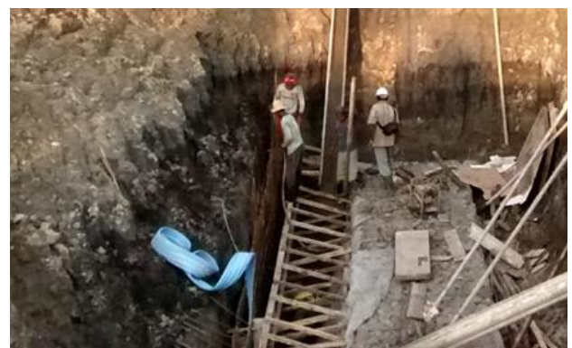
Gambar 14. Internal Vibrator pada pekerjaan pondasi penahan dinding
