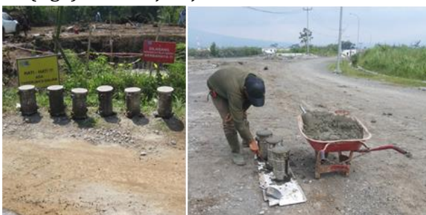
Gambar 12. Pengambilan benda uji untuk keperluan strength test beton
