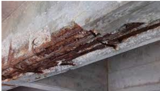
Gambar 1. Korosi Beton [8]
