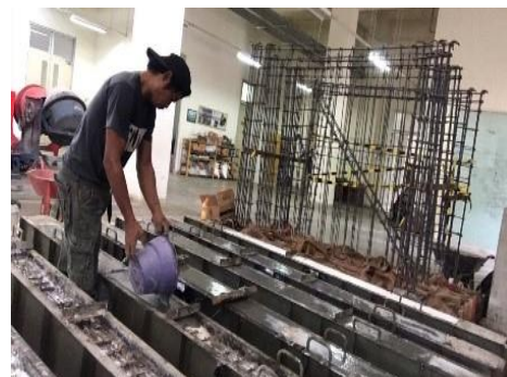
Gambar 7. Pencampuran SikaGrout 215 dan Air
