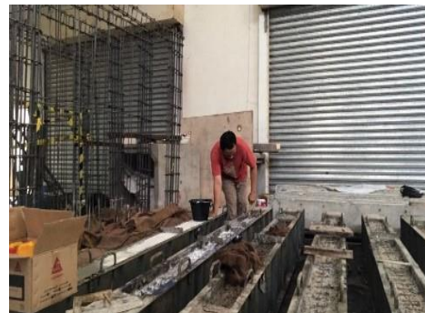
Gambar 6. Pembersihan dan Pengolesan Bonding Agent
