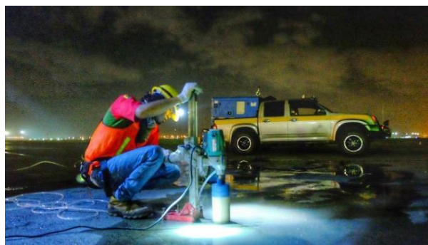
Gambar 10. Pengambilan Sampel Beton Inti
