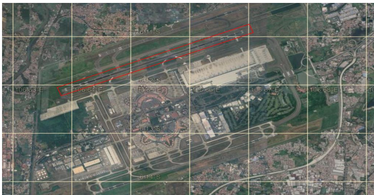
Gambar 1. Posisi Runway Utara di Bandar Udara Soekarno Hatta
