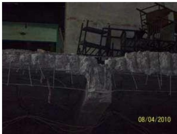
Gambar Tulangan Balok Balkon (Cantilever)
