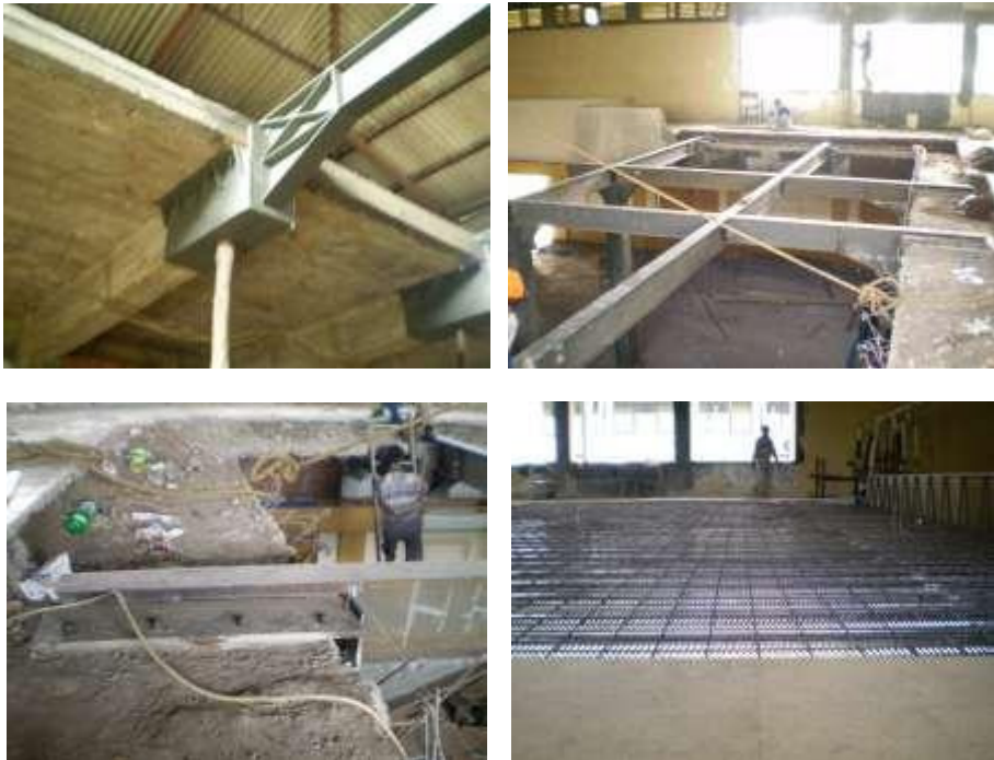
Gambar 7. Pemasangan di lapangan dari hasil analisa perhitungan
