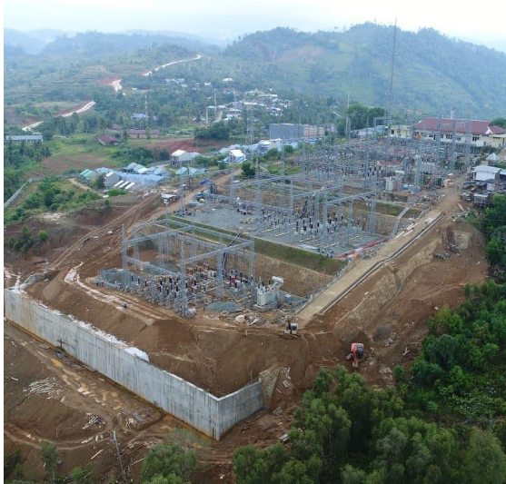
Gambar 12. Pengurugan dan Pemasangan Geotekstil
