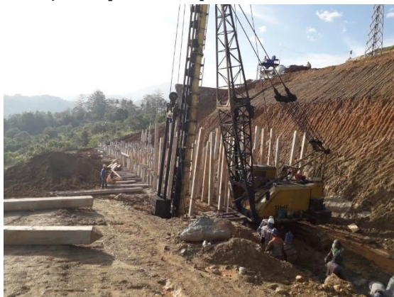
Gambar 9. Persiapan Lahan dan Pemancangan
