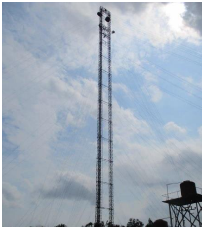
Gambar 2. Tampak Menara Telekomunikasi
