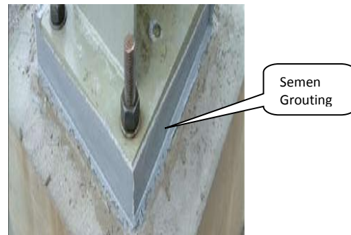
Gambar9 : Pemasangan semen grouting
