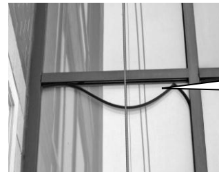
Gambar 11 :Gasket kaca lepas dari dudukan rangka facade curtain wall
