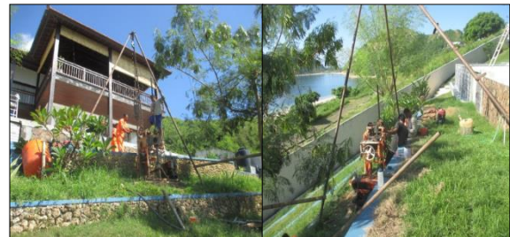
Gambar 2. Lokasi penyelidikan geoteknik (Anonim, 2018)
