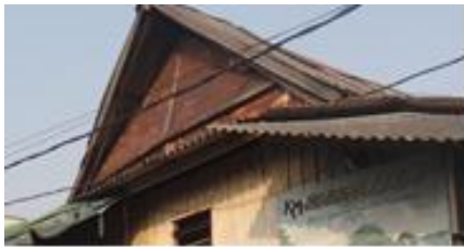
Gambar 18. Atap pelana berbahan asbes
