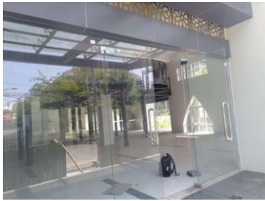
Gambar 9. Detail Dinding Eksterior Gedung Perpustakaan. (Sumber: Dokumentasi Pribadi, 2021)
