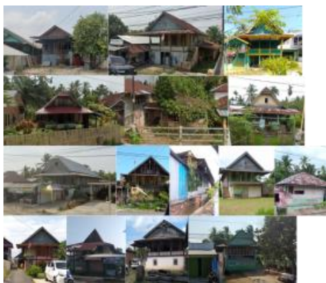
Gambar 2 Foto dokumentasi rumah panggung kombinasi kayu dan beton tipe 1 (Sumber: Dokumentasi Pribadi, 2021)
