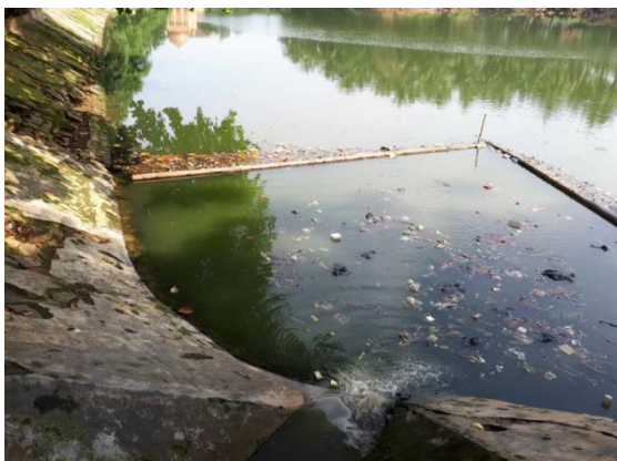
Gambar 6. Limbah Permukiman pada Inlet Setu Mangga Bolong (Sumber: Dokumentasi)
