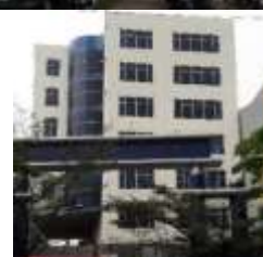
Gambar 11. Bangunan Sarana Kesehatan Muhammadiyah (Sumber: Dokumentasi Pribadi, 2017)
