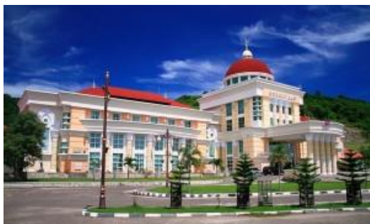
Gambar 4. Kantor Gubernur Pemerintah Propinsi Gorontalo yang terletak di atas Bukit terinspirasi dari Capitol Hill di Washington DC. Curamnya jalan menyulitkan kendaraan roda dua untuk mencapai bangunan tersebut. (Sumber: http://pesonawisataindonesia.com/pesona-wisata-gorontalo-kantor-gorontalo/ )
