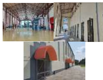
Gambar 24. Struktur Tampak Dalam (Kiri), Struktur Tampak Luar (Tengah, Kanopi Pada Fasad (Kanan) (Sumber: Dokumentasi Pribadi, 2023)
