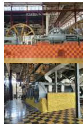
Gambar 22. Podium Mesin Stasiun Gilingan (Kiri), Dinding Penopang Mesin Stasiun Penguapan (Kanan) (Sumber: Dokumentasi Pribadi, 2023)
