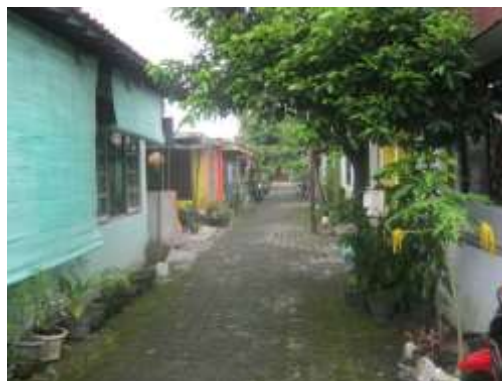
Gambar 4. Kondisi Jalan Lingkungan (Sumber: Observasi Lapangan, 2018)
