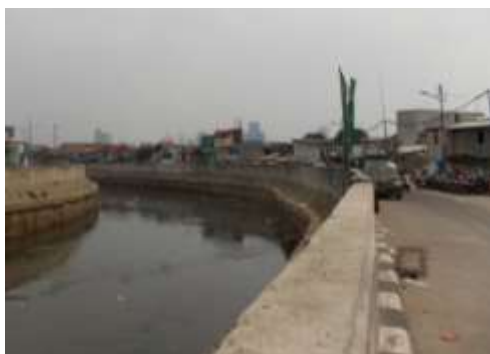
Gambar 1. Normalisasi Sungai Ciliwung dan pembangunan jalan inspeksi di Kampung Pulo
