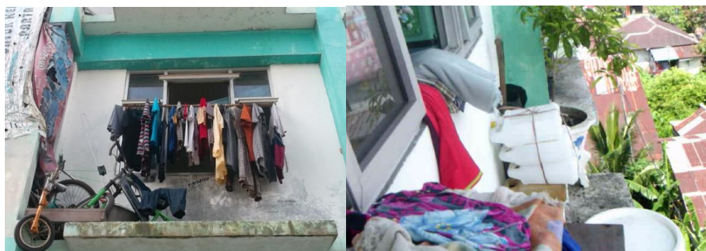
Gambar 5. Memanfaatkan ruang luar jendela untuk menjemur pakaian dan menyimpan barang pada Rumah Susun Sederhana Sewa (Rusunawa) Di Kelurahan Sungai Beliung Kota Pontianak (Sumber : Dokumentasi Penulis, 2014)
