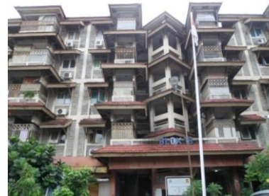
Gambar 5. Rumah Susun Tebet Barat 1, lokasi Tebet Barat, Kel. Tebet, Kec. Tebet, Jakarta Selatan. (Sumber : Dokumentasi Pribadi, 2014)
