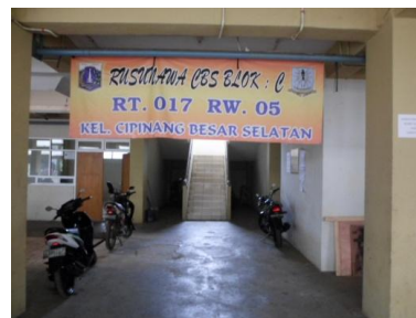
Gambar 4. Rumah Susun Cipinang Besar Selatan (Cibesel) Kel. Cipinang Besar Kec. Jatinegara Jaktim. (Sumber : Dokumentasi Pribadi, 2014)
