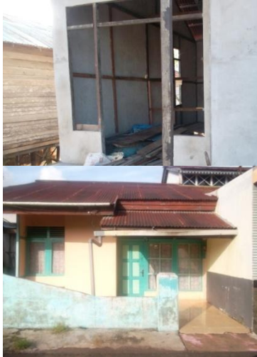
Gambar 4. Salah satu bentuk tampilan rumah dengan dinding simpai (dinding luar rata dan dinding dalam ekspose rangka kayu)
