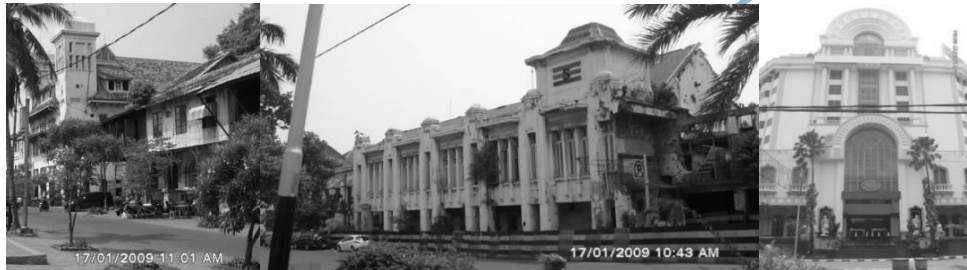
Gambar 12. Fasade bangunan pada kawasan tepi sungai Ciliwung di Jakarta Kota (Sumber : pribadi, 2011)
