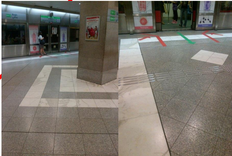
Gambar 2. Pola diagonal pada elemen lantai di Stasiun Bugis dan varian warna putih pada beberapa area seperti di kolom dan dekat akses keluar-masuk gerbong kereta (foto oleh penulis).
