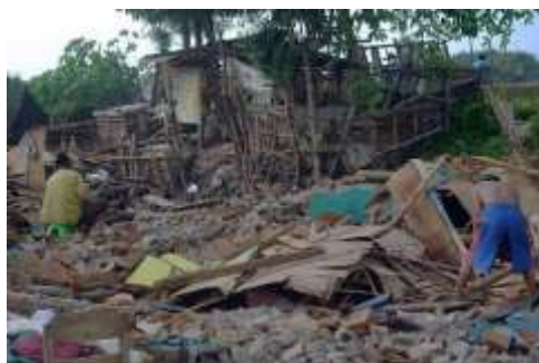
Gambar 1. Permukiman ilegal di Semanggi, Solo pasca pembongkaran (sumber: Dokumentasi penulis, 2019)
