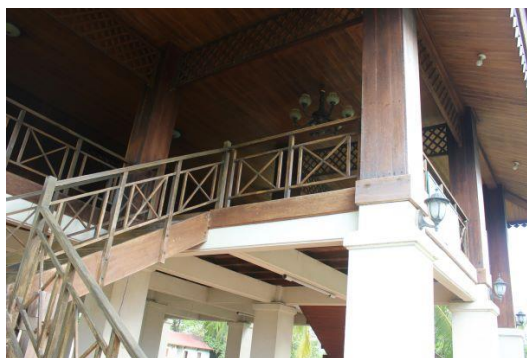
Gambar 2. Jalamba permanen berbahan kayu pada teras dan tangga pada bangunan tradisional Dulohupa (Sumber: Dokumentasi Pribadi, 2015)
