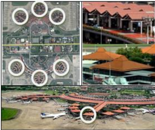
Gambar 1. bentuk bangunan dan atap joglo pada terminal 1 dan 2
