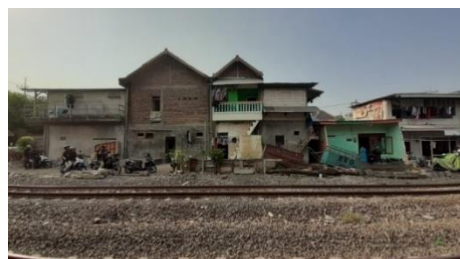
Figure 6. Kondisi Rumah di Kampung Lumumba Source: Penulis, 2020
