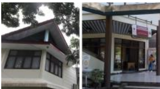
Gambar 5 Bentuk bukaan pada gedung dekanat FEB
