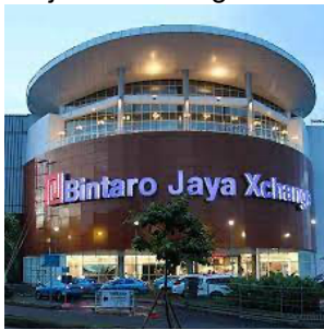
Gambar 1. Bintaro jaya Xchange Mall Sumber: DDG dan Aecom, 2005
