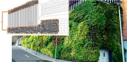
Gambar 4. Pemasangan vegetasi & kayu BXc Mall Sumber: Faras, 2019
