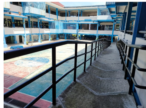
Gambar 5 Area Dalam Lingkungan SMKN 61 Jakarta Sumber: Dokumen Pribadi, 2021
