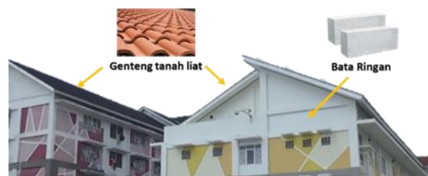
Gambar 3: Analisis Material Bangunan Sumber: Analisis Pribadi (2022)
