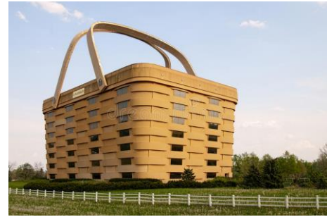
Gambar 1: Tampak Bangunan Longarberger Basket Company, Amerika Serikat
