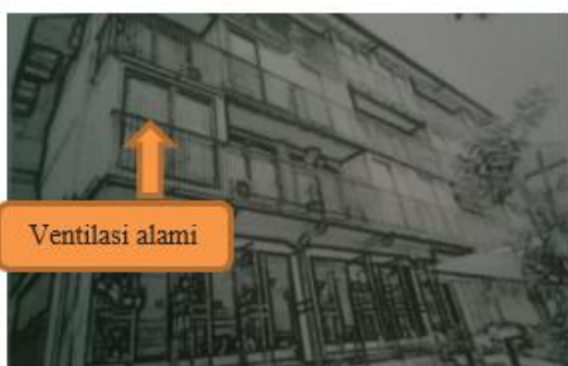
Gambar 11. ventilasi alami pada bangunan Kolektive Hotel. Sumber : Dokumen Pribadi, 2021
