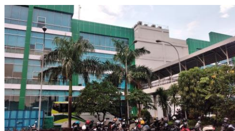
Gambar 13: Tampak Selatan Kantor Pusat PT. KBN Sumber: Sumber Pribadi (2023)
