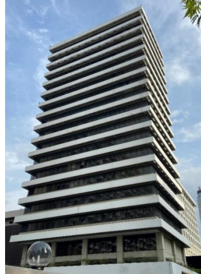
Gambar 2: Fasad Menara Cakrawala Sumber: Menara Cakrawala (2022)
