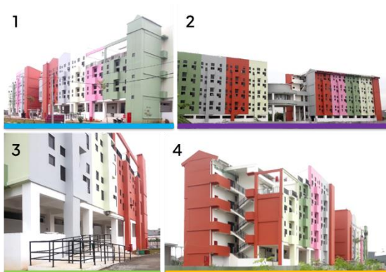
Gambar 4: Tampak Bangunan Kampung Susun Produktif Tumbuh Cakung Sumber: Data Pribadi (2022)
