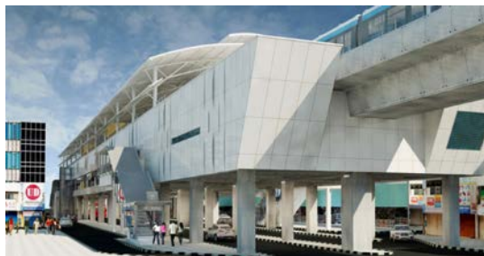
Gambar 1: Bentuk Massa bangunan Sumber: https://vik.kompas.com/mrt-jakarta/ (2023)
