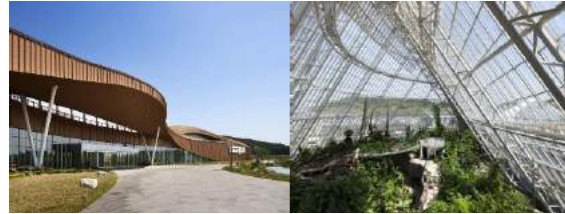
Gambar 5. Fasad dan struktur bangunan Sumber : Data Pribadi (2023)
