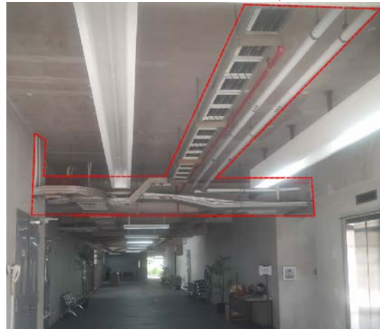
Gambar 20: Ekspos Pipa Plumbung dan Utilitas Listrik pada Lantai 1 Politeknik Universitas Multimedia Nusantara (Sumber: Data Pribadi, 2024)
