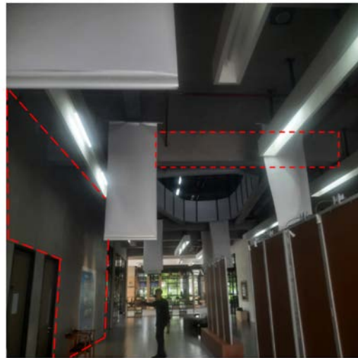
Gambar 12: Material Beton pada Dinding dan Balok Interior Politeknik Universitas Multimedia Nusantara Sumber: Data Pribadi (2024)
