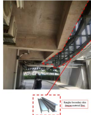
Gambar 8: Letak Material Rangka Besi pada Politeknik Universitas Multimedia Nusantara Sumber: Data Pribadi (2024)
