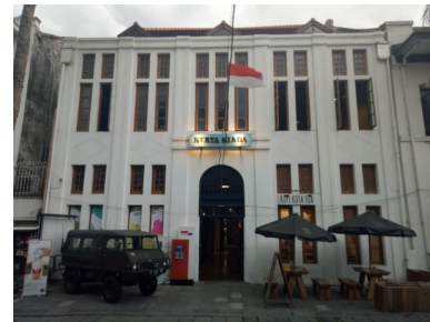
Gambar 6: Fasad Kerta Niaga Sumber: Dokumentasi Pribadi (2018)
