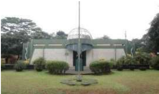
Gambar 2: Tampak depan Sumber: Dokumentasi Pribadi (2018)
