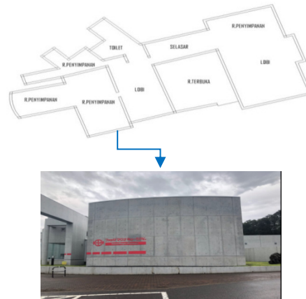
Gambar 6. Penggunaan Dinding Beton pada Museum Fossa Magna Jepang Sumber : Analisis Pribadi, 2019
