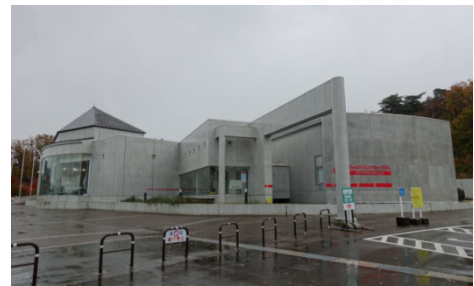
Gambar 10. Penggunaan Dinding Beton pada Museum Fossa Magna
